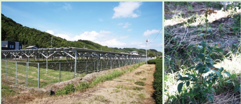
GPエナジーEの営農用太陽光発電所。太陽光パネルの下ではサカキを栽培
