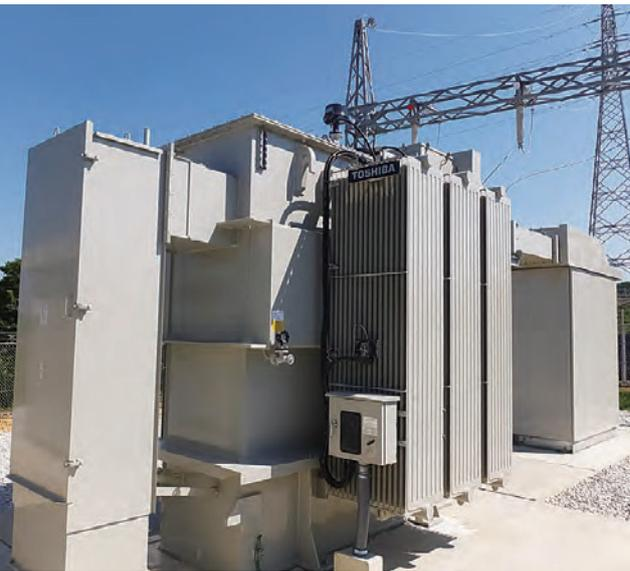
写真3 5MV・A 油入変圧器
