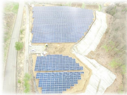
佐久市茂田井高圧 1 区画 パネル容量 818.4kW
