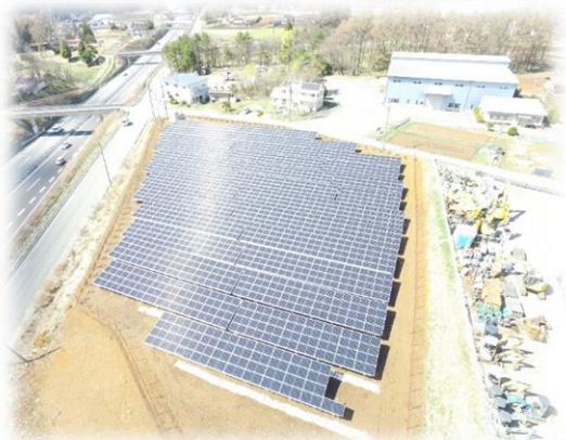
茅野市金沢高圧 1 区画 パネル容量 629.7kW
