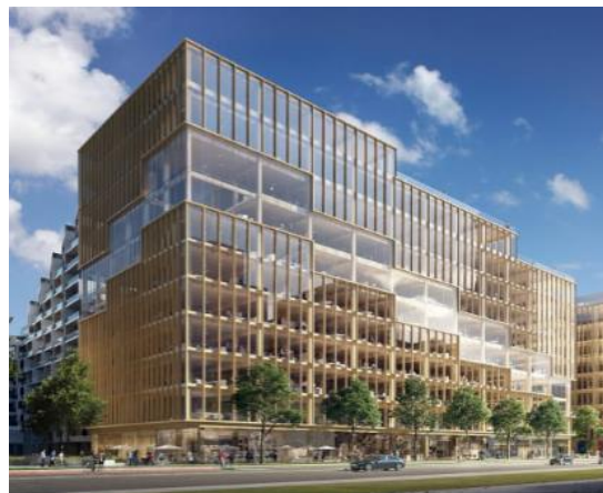
商業施設等の屋内向けインフラシェアリング
