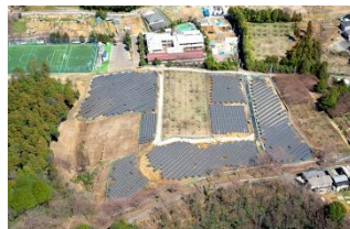
横浜市 初のメガソーラー発電所
