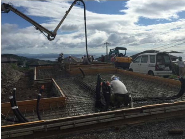
別府地熱発電所の設置工事
