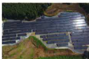
②鹿屋大浦発電所(650Kw)
