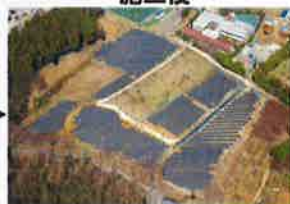
①神奈川県横浜市発電所(1.2Mw)
