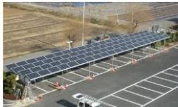
カーポート型PV発電システム
