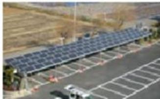
カーポート型PV発電システム
