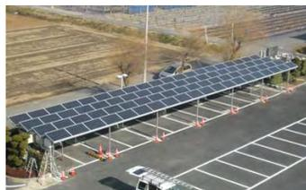
カーポート型PV発電システム
